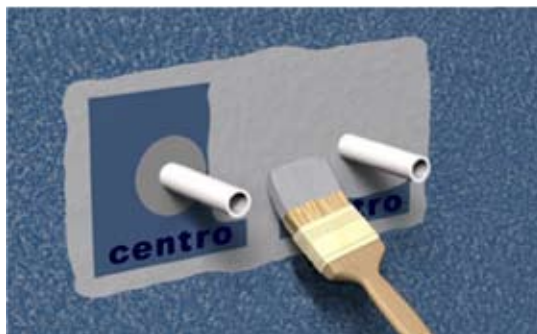
12. Montera Centro Rörmanschett för avsedd rörstorlek. Manschetterna monteras med Centro TM#10.
